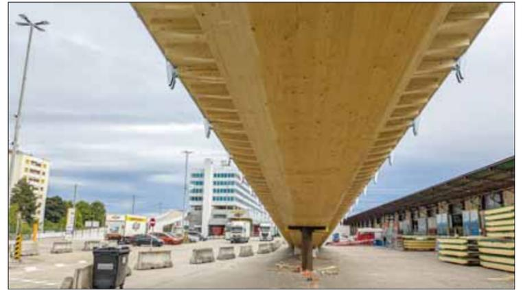
Radweg aus Brettschichtholz auf bis zu 7 m hohen Stahlstelzen Fotos: Urb-x
